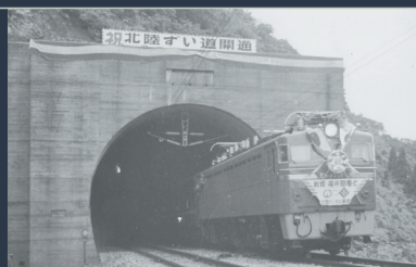
北陸トンネル開通の様子 当時の日本最長となる北陸トンネルが開通し、峠越えの路線は廃線になりました。
